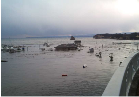
孤立状態になったクラブハウス (奥は修理工場)
