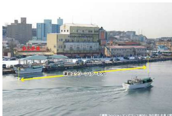
写真－3.8 漂流防止柵例(北海道釧路市「津波スクリーン」)
