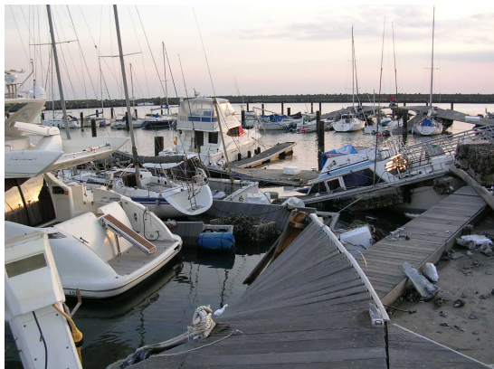
損壊した栈橋の一部は、 たわむように変形した
